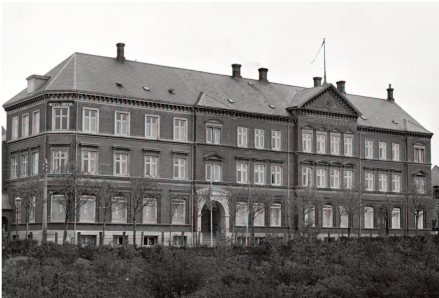
Hotel Royal i Havnegade 45. Ejendommen blev revet ned i 1976. Foto: EBA 73917-070
